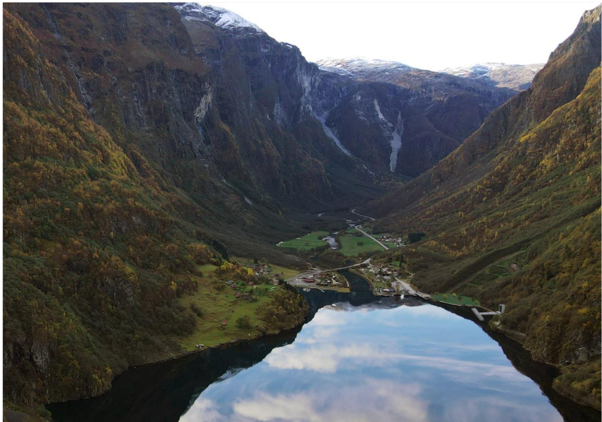
Figur 24: Fotomontasje for alternativ 2 med ny kai, tilkomst via ny industitunnel, vest for Gudvangen (Opus)
