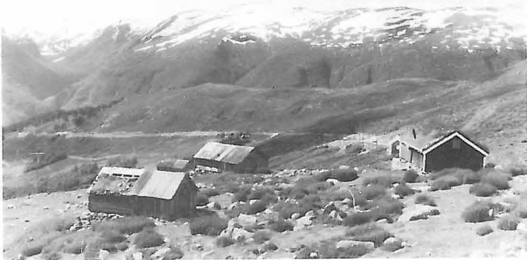
Stølsgrenda Kvammadalen. Ei av mange stølsgrender i Aurland der husa står til nedfall på grunn av at dei ikkje er i bruk.
