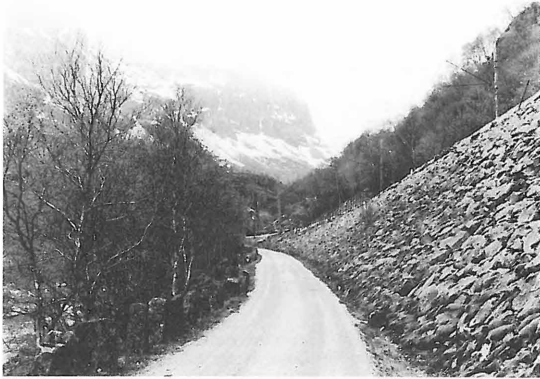
Anleggsvegen i Flåmsdalen.
